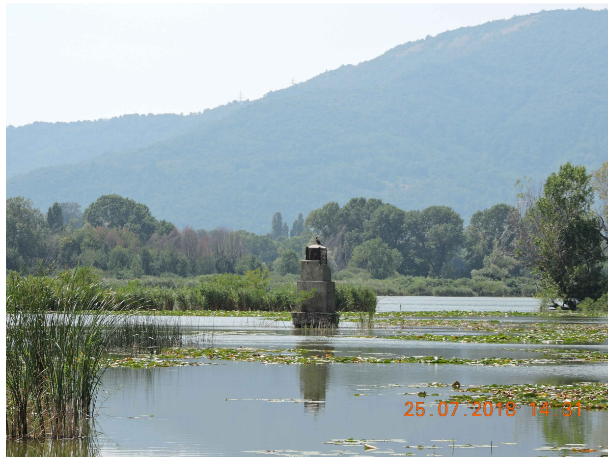
Immagine 1 - ex pilone su cui fissare uno dei due nidi
